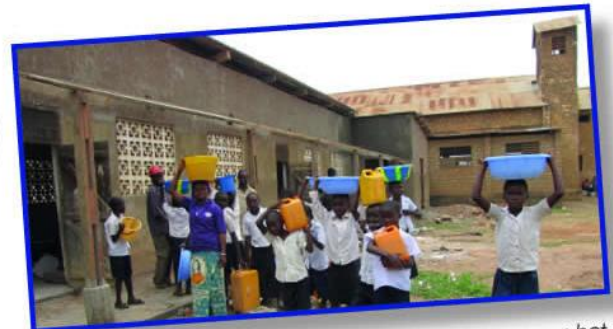
Leerlingen brengen water, zand en stenen aan voor het metselwerk.
