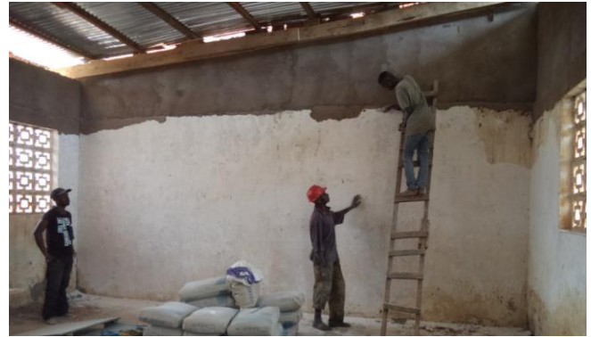
De muren werden opgehoogd. Er ligt een nieuw stevig dak op.
