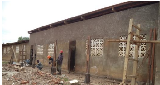
Vergelijk de hoogte van de gerenoveerde klassen met die van de oude lokalen.
